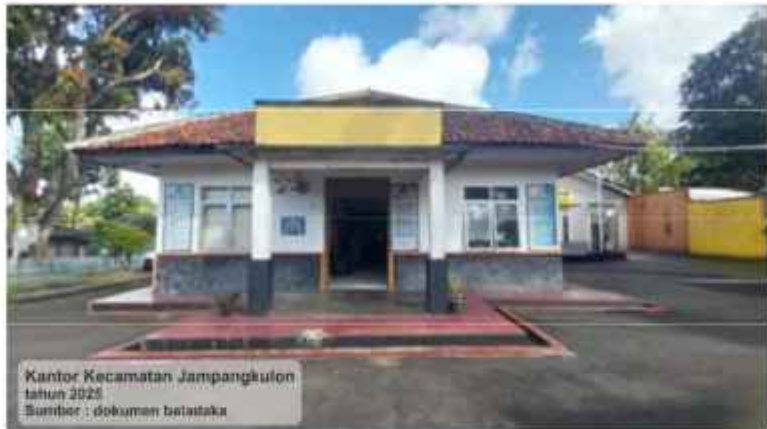
Kantor Kecamatan Jampangkulon
